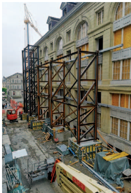
Charpente du côté de St-Michel. © J.-M. Dücrey / BCU Fribourg
