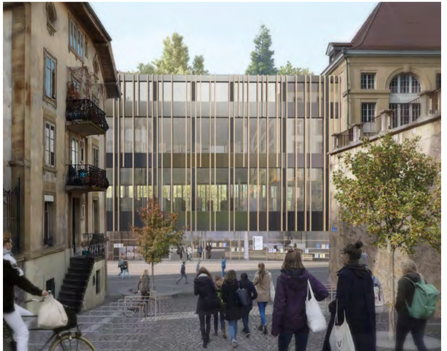
Un bâtiment clairement structuré, transparent à l'extérieur et facilitant l'orientation à l'intérieur.
