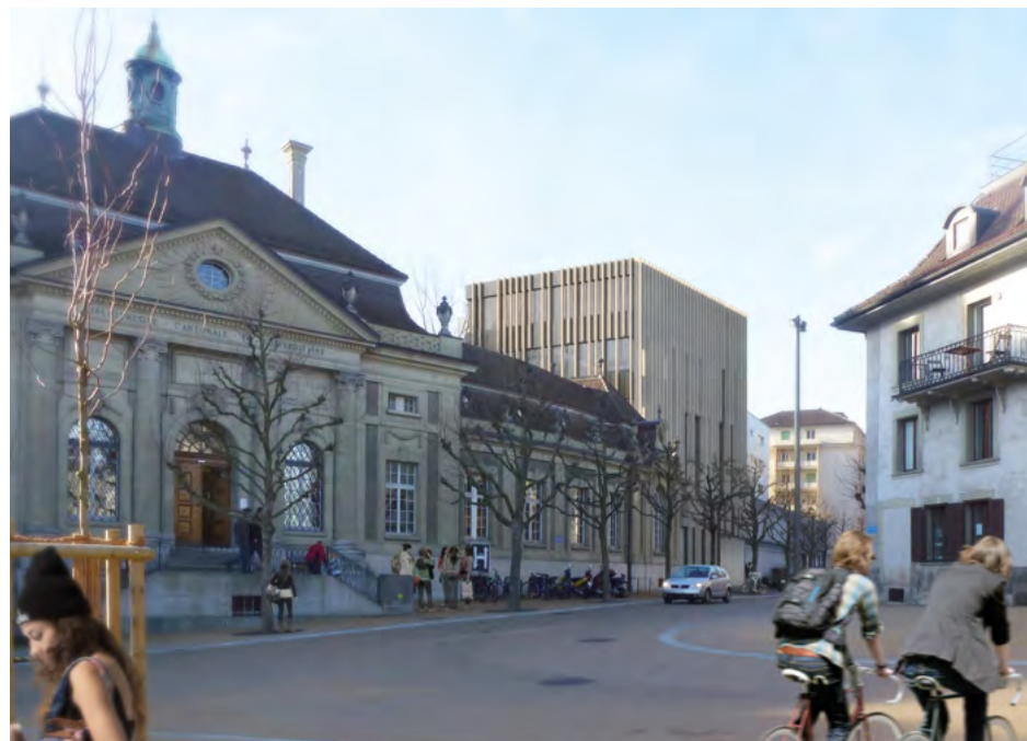
Un bâtiment emblématique centenaire, encadré par une extension moderne et respectueuse.
